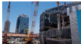
建設現場の作業連絡
